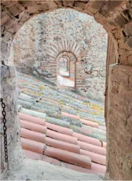
Teulada de la nau lateral dreta
