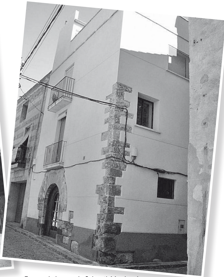
Façana de la casa de Sebastià Masdeu, la núm. 54 del carrer de Jaume I de Vilaplana.
